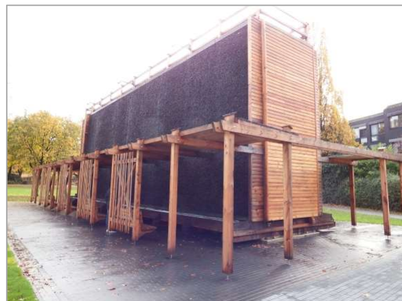
Gradierwerk im Kurpark
