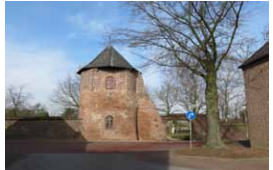
ABB 038 Wallmauer Quelle: Wolfram Reinhardt
