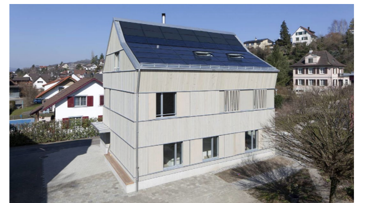
Photovoltaikdach, Ernst Schweizer
